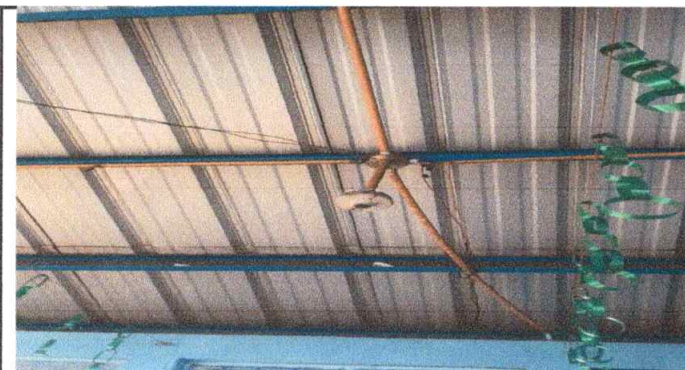
Foto 3: Reparacion de sistema eléctrico en módulo I, II, III y IV,
